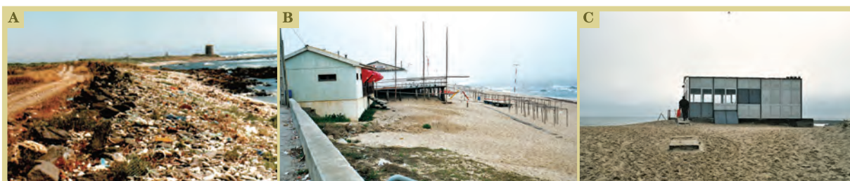
FIGURA 1 - A) DEPOSIÇÃO DE RESÍDUOS NO LITORAL; B) APOIOS DE PRAIA SEM CONDIÇÕES; C) CONSTRUÇÕES DEGRADADAS
