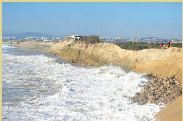
EROSÃO MARINHA: UM RISCO BEM REAL
