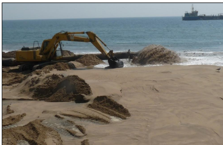
Figura 3 – Aspeto dos trabalhos de repulsão da areia na praia emersa.
