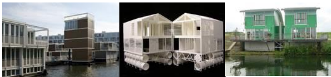
Figura 8.34 - Estruturas sobre flutuadores na Holanda (fonte: Design Ideas Daily, Factor Architecten, Florian Holzherr).
