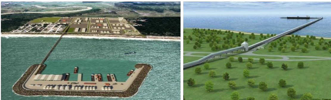
Figura 8.29 - Obra portuária destacada (fonte: http://www.urs.com/projects/pedro-de-ferro-offshore-port/ )
