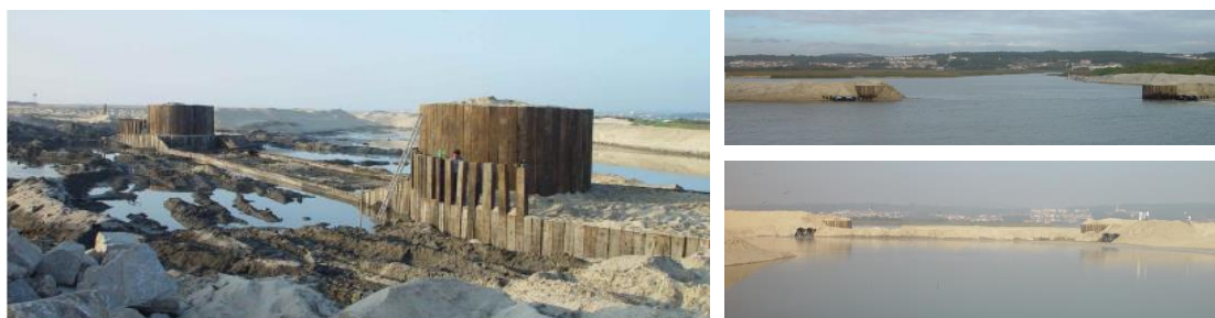
Figura 8.31 - Dique fusível da Barrinha de Esmoriz com pormenores na fase de construção e com a ligação ao mar aberta e encerrada (fonte: ARH Centro).
